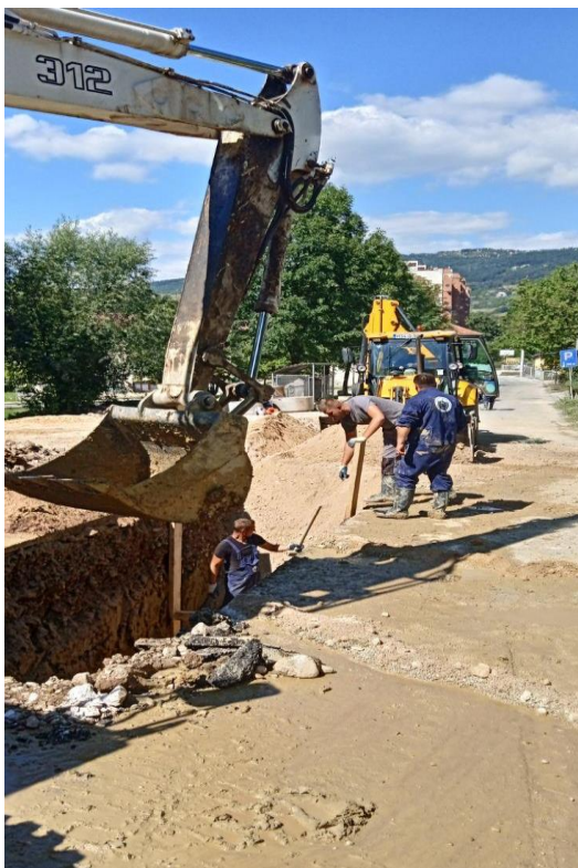
Slika 12. U ulici Jukićeva radovi na rekonstrukciji kanalizacione mreže (13.09.2021.)
