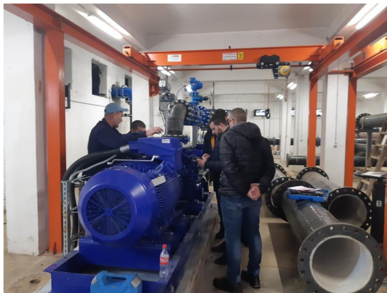
Slika 11. Puštanje u rad novih pumpnih agregata (30. 11. 2021.)
