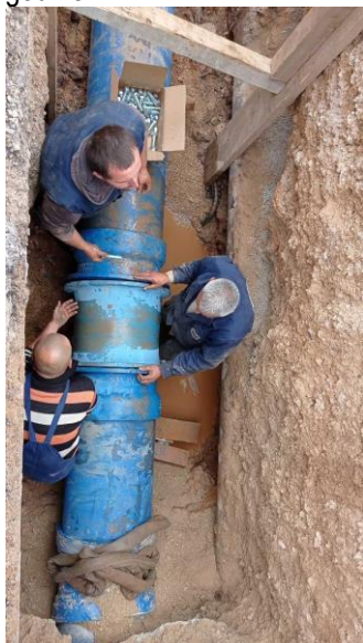
Slika 11. Radovi na uvezivanju dijela rekonstruisanog potisnog cjevovoda za pravac pumpanja Alipašin most – Centar (22. 09. 2021.)
