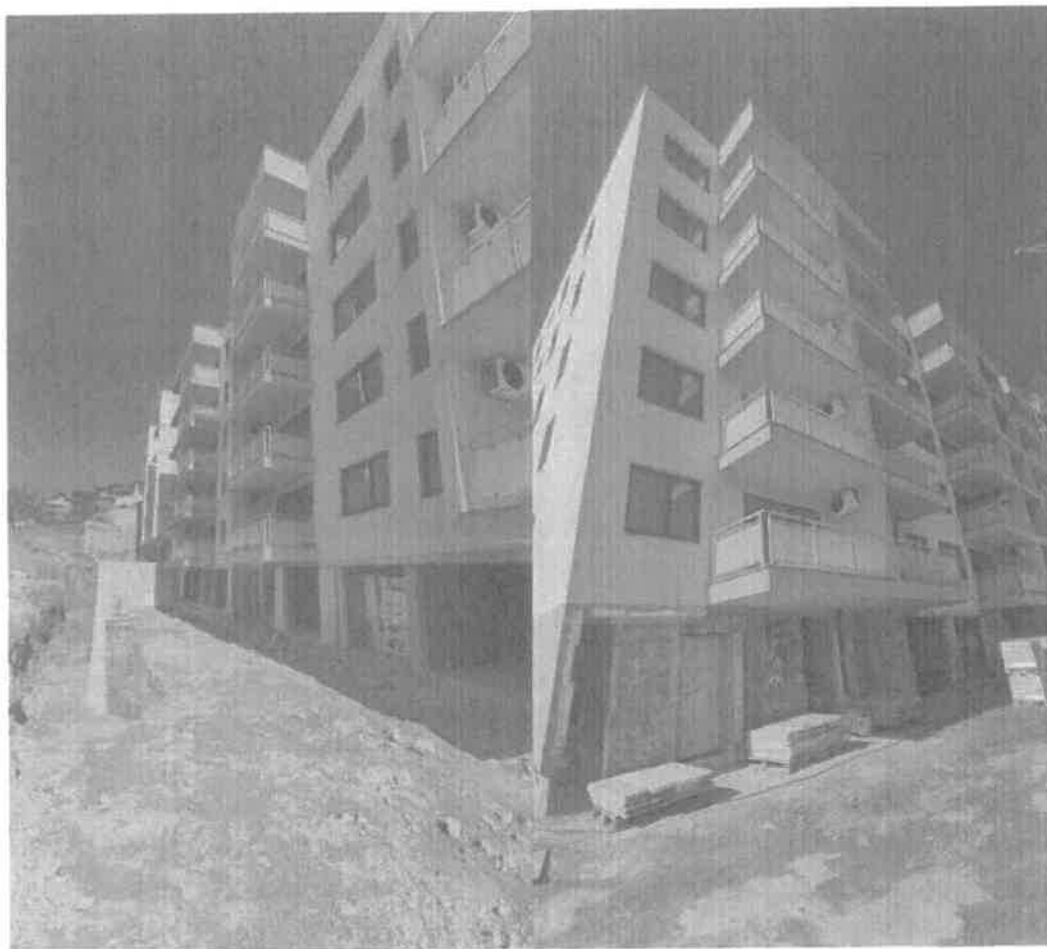
Fotografije objekta gdje se evidentira da je objekat u finalnoj fazi realizacije posla sa vanjskom obradom fasada
