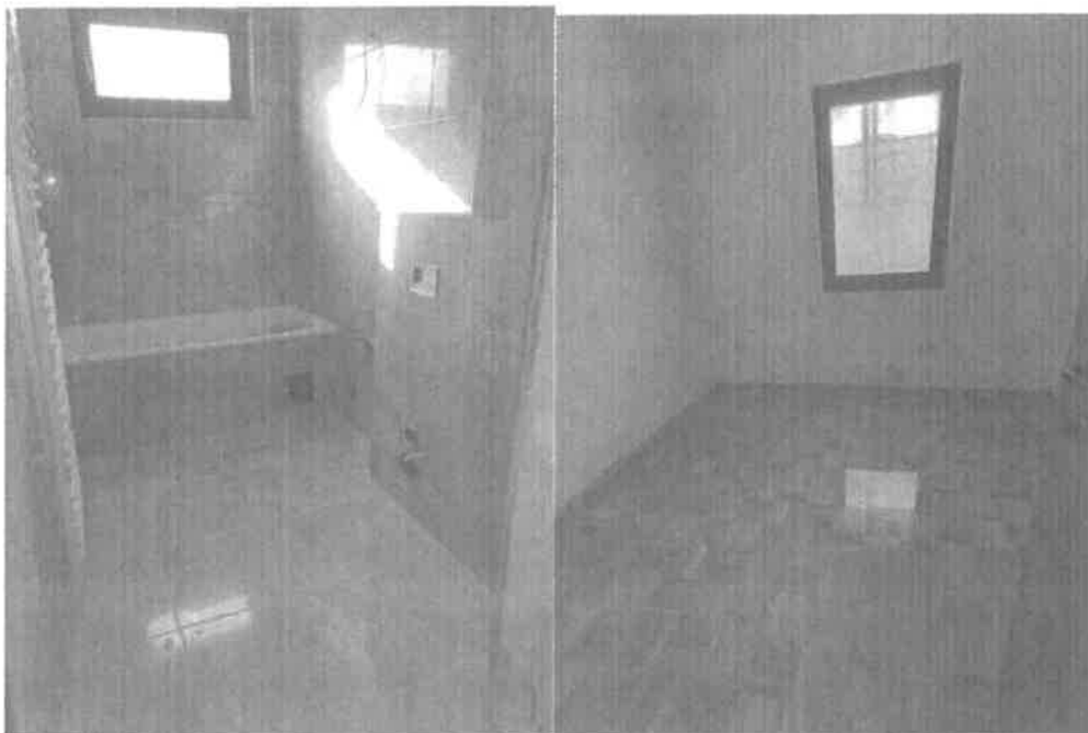
Fotografije toka realizacije posla, na unutrašnjosti obradi enterijera objekta koji se trenutno realizira
