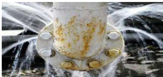
Slika 7. Tehnički gubici - curenje na ventilu
