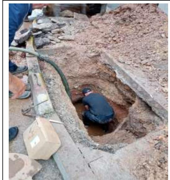
Slika 3. Opravke kvarova na glavnim vodovodnim cjevima u ulici Ibrahima Ljubovića. (07.11.2022.g.)
