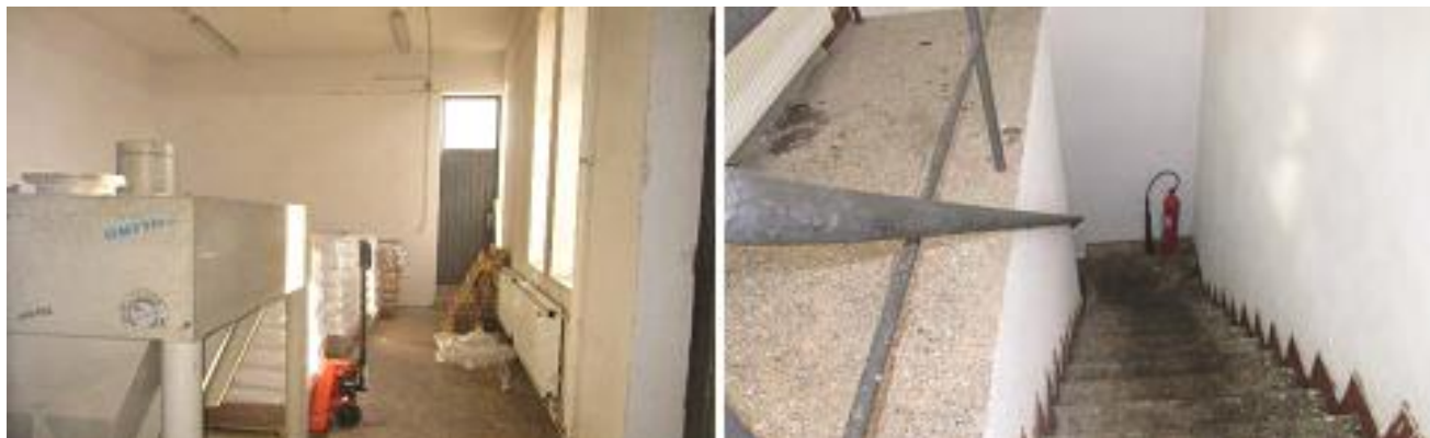
Slika 61: objekat za zgušnjavanje i odvodnjave mulja—Izvor: terenska inspekcija nekretnine
