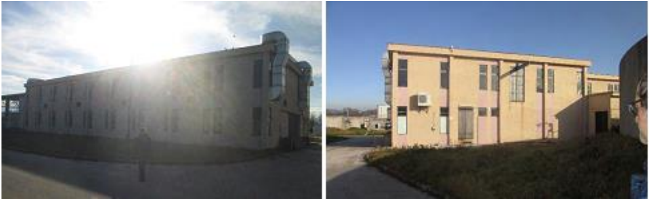
Slika 58: objekat za zgušnjavanje I odvodnjavanje mulja – Izvor: terenska inspekcija nekretnine
