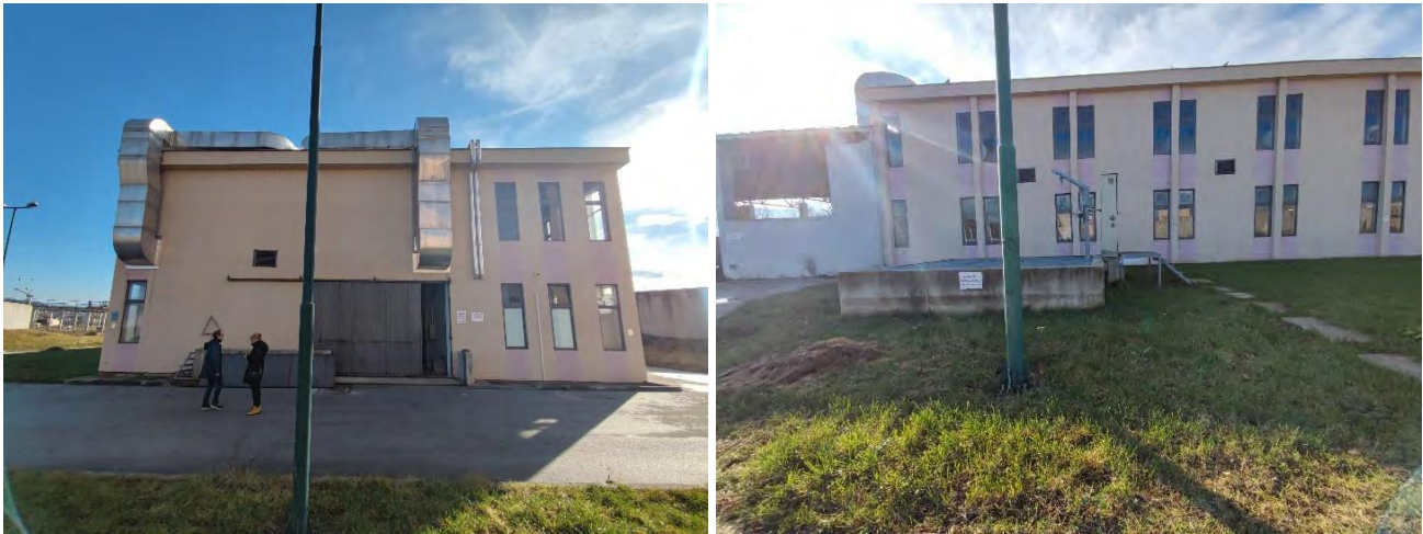
Slika 59: objekat za zgušnjavanje I odvodnjavanje mulja – Izvor: terenska inspekcija nekretnine
