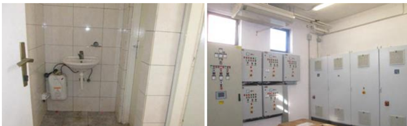
Slika 62: objekat za zgušnjavanje i odvodnjavanje mulja – Izvor: terenska inspekcija nekretnine
