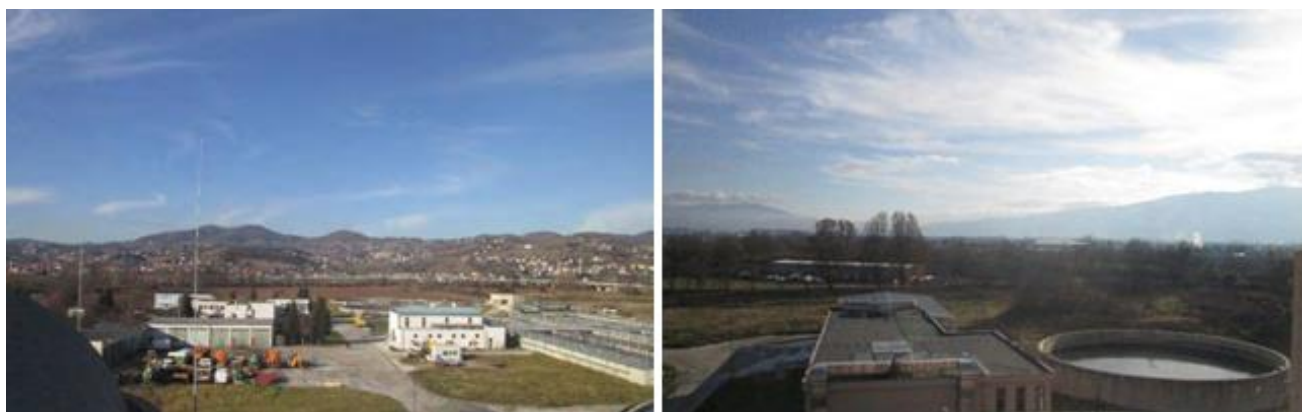
Slika 10: predmetni poslovni objekat – Izvor: terenska inspekcija nekretnine
