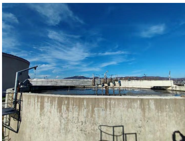
Slika 73: ugušćivač mulja sa pumpnom stanicom – Izvor: terenska inspekcija nekretnine
