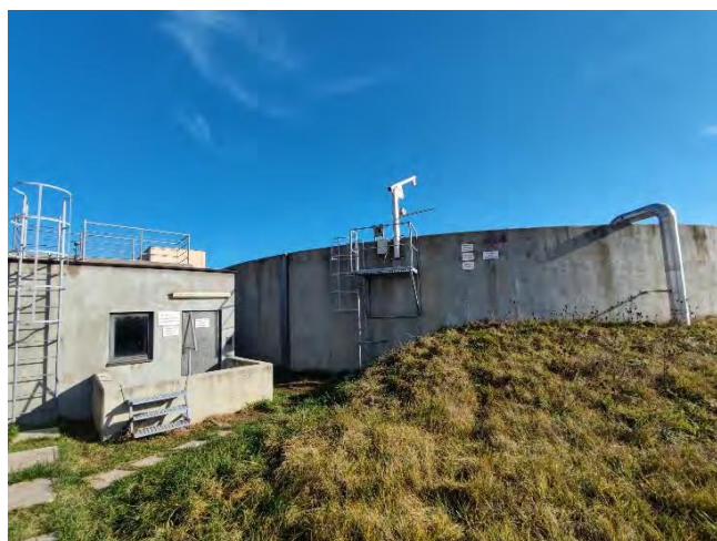
Slika 72: ugušćivač mulja sa pumpnom stanicom – Izvor: terenska inspekcija nekretnine
