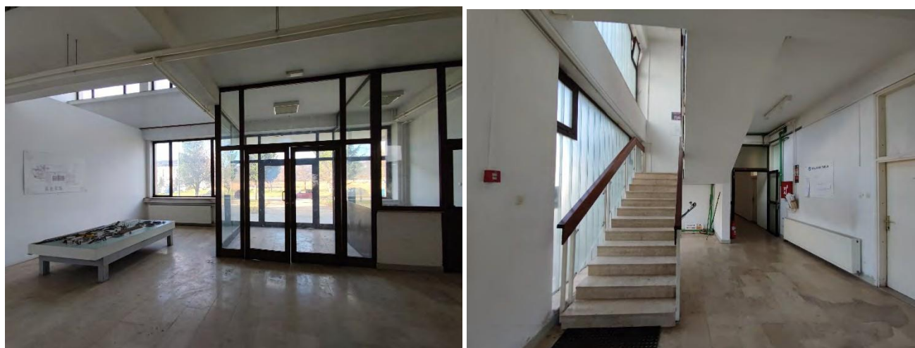
Slika 17: ulazni hol u upravnu zgradu – Izvor: terenska inspekcija nekretnine
