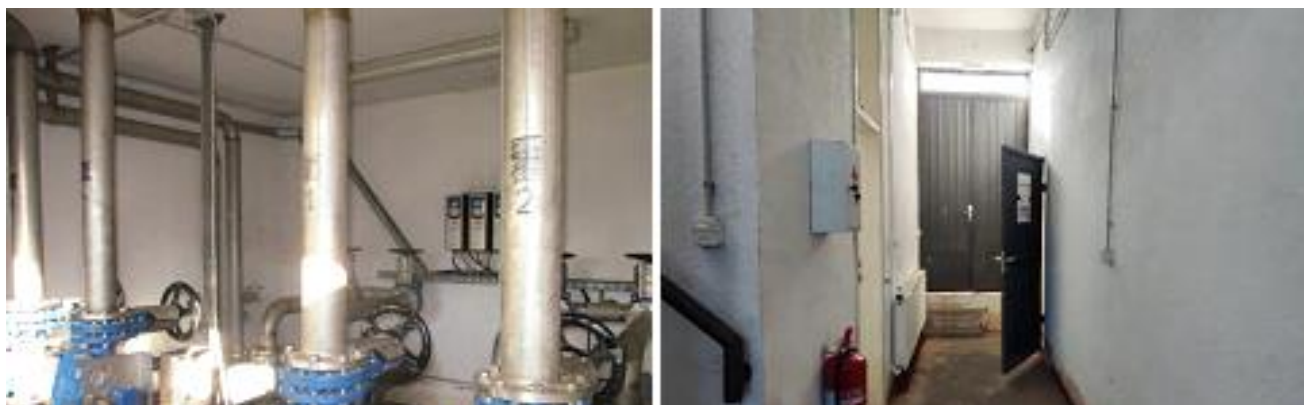
Slika 63: objekat za zgušnjavanje i odvodnjavanje mulja—Izvor:terenska inspekcija nekretnine
