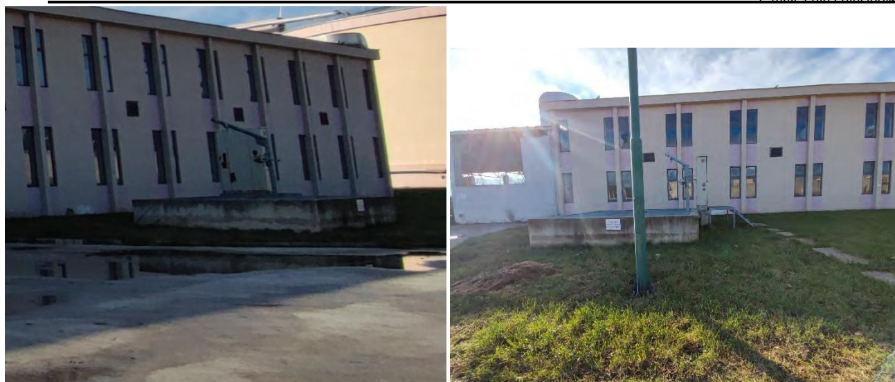
Slika 68: pumpna stanica muljnog filtra – Izvor: terenska inspekcija nekretnine
