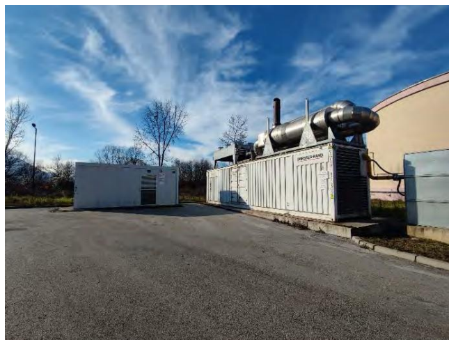
Slika 52: kogeneracijsko postrojenje – Izvor: terenska inspekcija nekretnine: www.katastar.ba/geoportal/preglednik/
