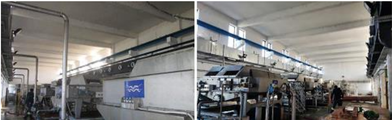
Slika 60: objekat za zgušnjavanje I odvodnjavanje mulja – Izvor: terenska inspekcija nekretnine
