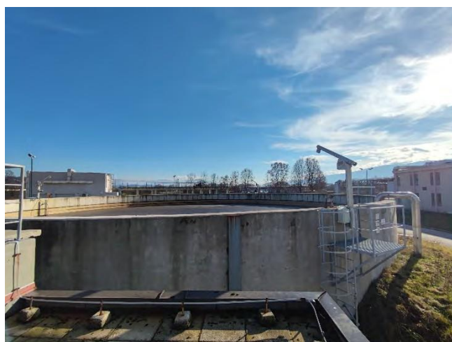
Slika 73: ugušćivač mulja sa pumpnom stanicom – Izvor: terenska inspekcija nekretnine
