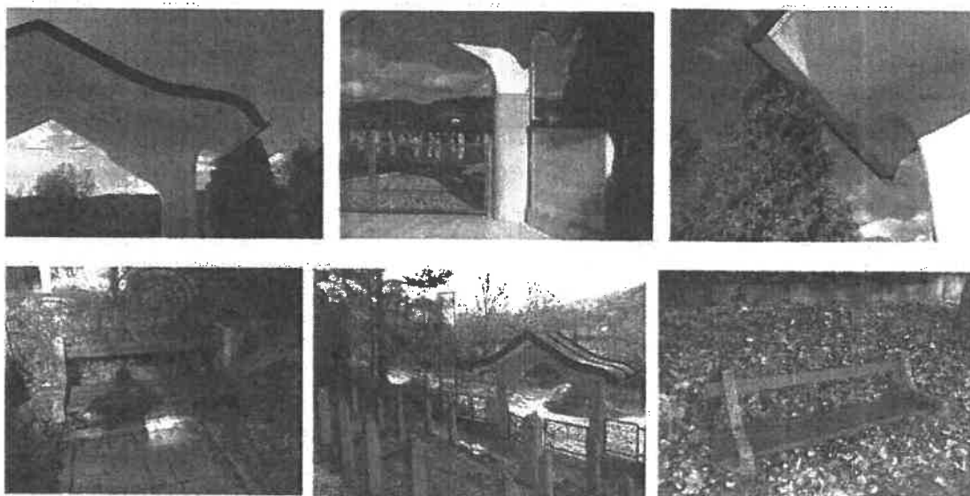
Mezarje Kijevo, popravljene i ofarbane klupe uz manje intervencije na ulaznoj kapiji
