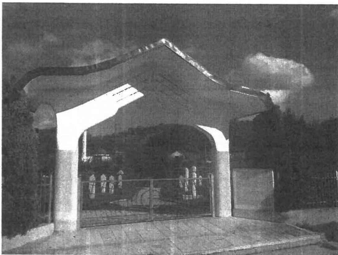
Mezarje Lješevo; sanacija krova tipske ulazne AB kapije (El-Fatiha) i bojenje stubova i postamenta
